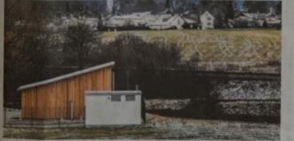
Die beiden Betriebsgebäude sind im Vordergrund zu sehen, im Hintergrund den Blick auf die „Skyline“ von Edling.
